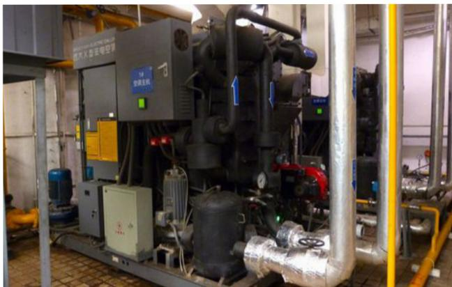
地下室有一台远大吸收式空调，用发电机的废热驱动，废热同时也供给洗衣房。与用常规方式建成的酒店相比，T30酒店只使用了1/5的能源，1/4的水，室内空气比室外空气洁净20倍，你能很明显地感觉到差异。我曾在纽约一个号称绿色
