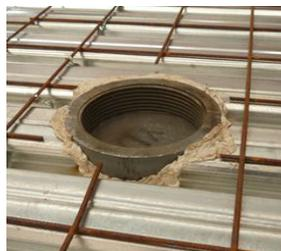
还有一个我以前没有留意到的很棒的细节：每层地板之中都有4个带螺纹套管的管道，这样可以让他们很好的立在支柱上，方便工人在下面作业、安装部件并堆放装运，也为吊车提供了一个钩点，如果建造速度是远大系统唯一值得称道的地方，那也够了，但就TreeHugger的观点而言，还有很多有价值的地方。
